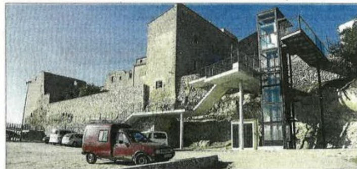
En Lloret se ha hecho un ascensor panorámico que une la zona del colegio con el casco antiguo.
